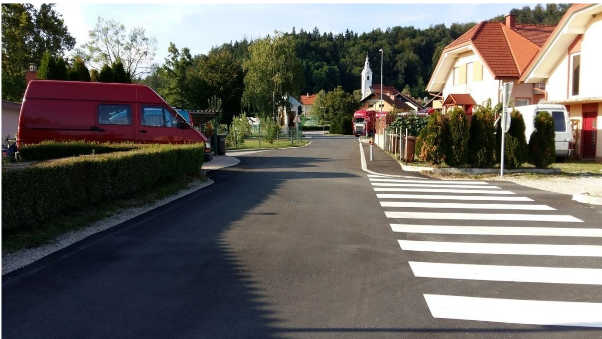
Slika 2: Šolska cesta proti vrtcu Krtek Šolar hodi po pločniku ali levem robu cestišča.
